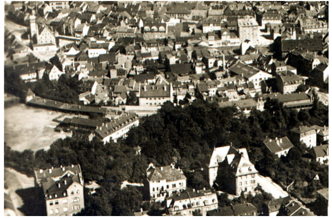
Wohnturm und anschließende Schuppen
