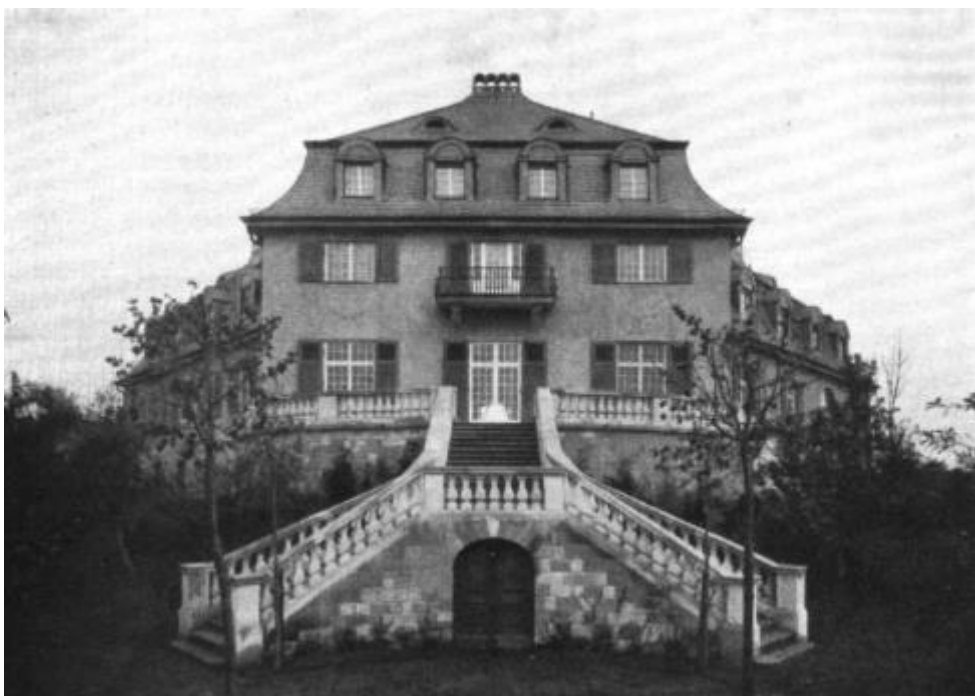
Villa Hedwig Fichtel-Graetz (Nordwestansicht)
