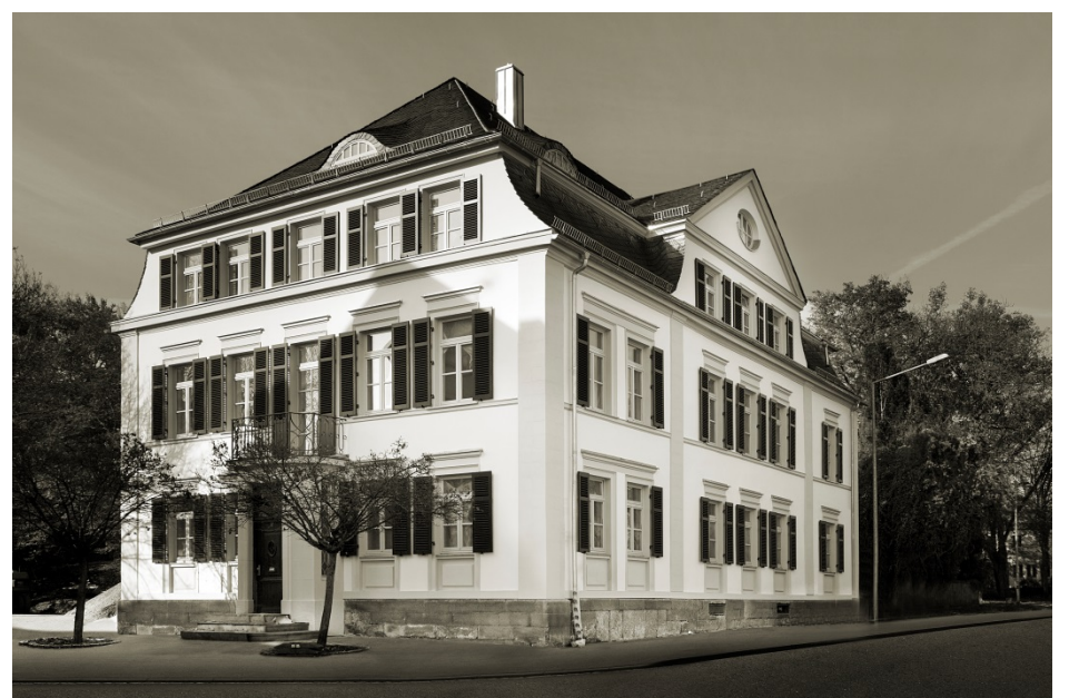
Kornmarkt 17 nach der Sanierung
