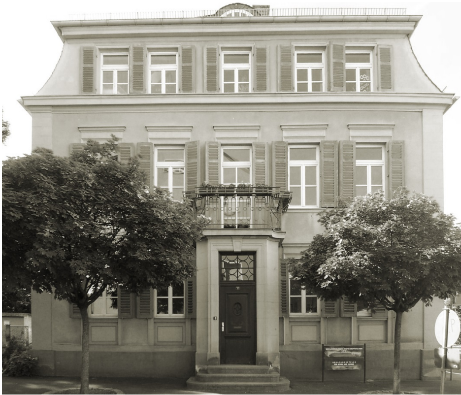
Kornmarkt 17 vor der Sanierung
